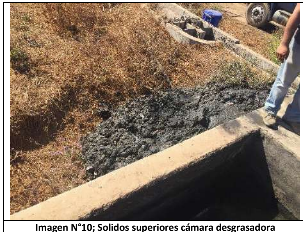
Imagen N°10; Solidos superiores cámara desgrasadora
